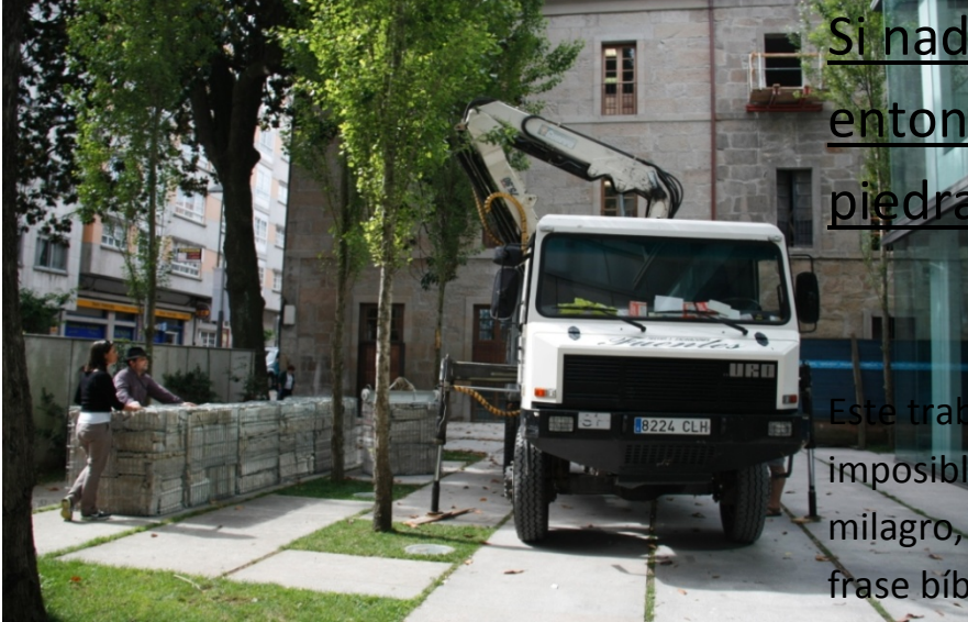
Proceso de construcción del muro
