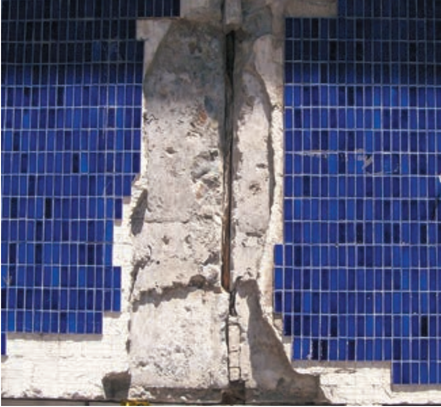
Detalle fachada Edificio INP, fotografía: Leonardo Portus, noviembre 2011.
